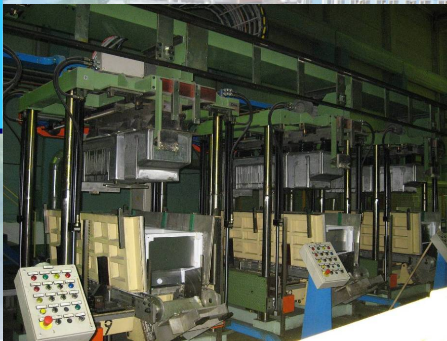
Линии заливки шкафов с защитными боксами
