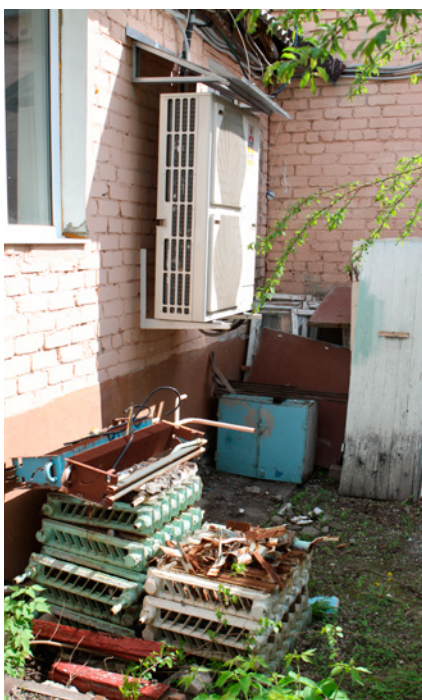
Пришлось менять отопление. На снимке — прошлое и будущее отопления школы
