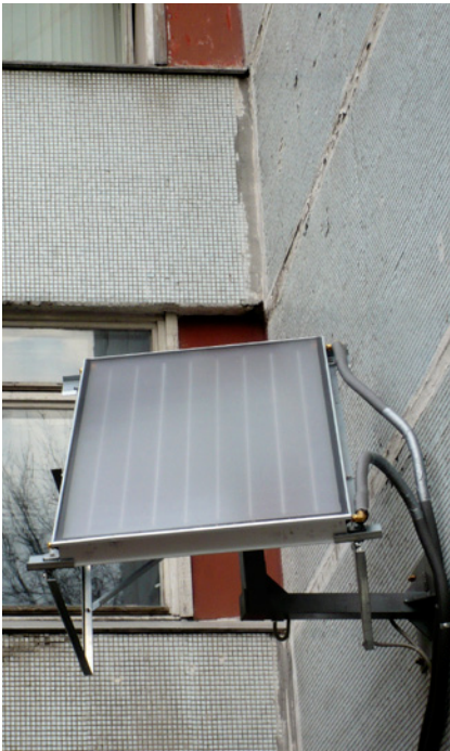
Политехнический колледж № 19, учебный стенд «Энергоэффективная система газового отопления и водоснабжения с возможностью дополнительного подогрева воды за счет солнечного коллектора»
