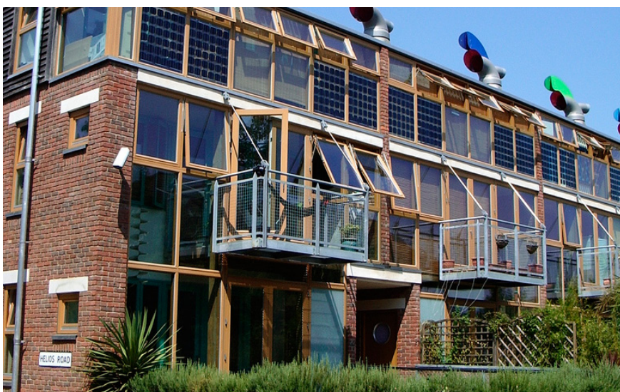
В BED ZED применено преимущественно южное остекление фасадов, что дает возможность максимально использовать естественный свет и тепло
