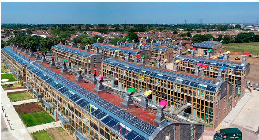
Здания спроектированы таким образом, чтобы каждая квартира имела выход на небольшое частное пространство с зеленью
