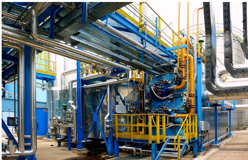
**Котел для производства перегретой воды для центрального отопления**
