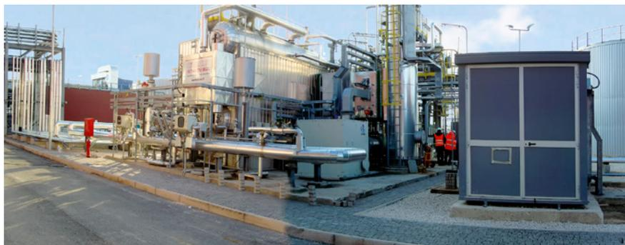
**Водотрубный паровой котел для запуска паровой турбины**
