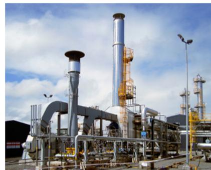
**Нагреватель термальной жидкости на нефтеперерабатывающем заводе**
