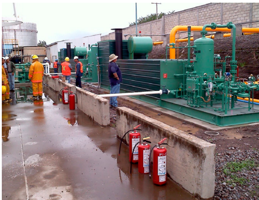
Начальный этап монтажа системы резервного топлива «пропан-эйр»
