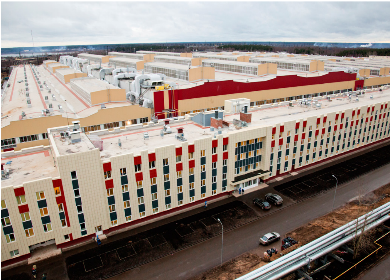
Производственные цеха Тихвинского вагоностроительного завода после реконструкции (более 200 тыс. кв. м)
