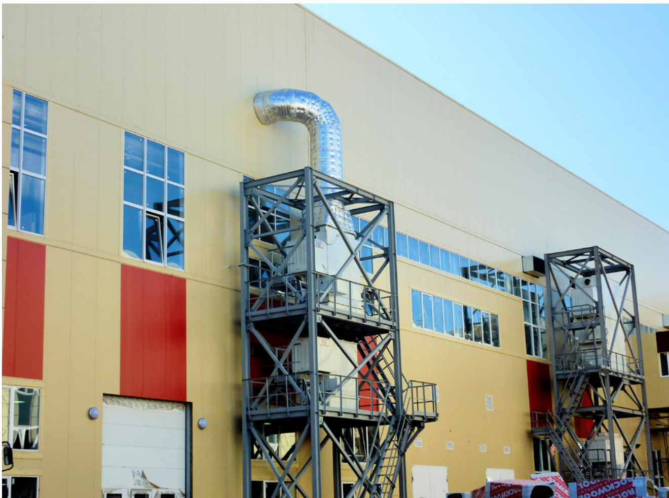
Вертикальная наружная установка для отопления
